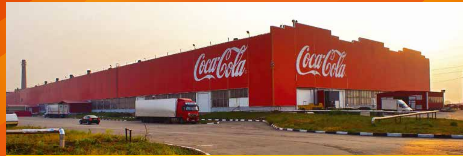
Щиты НКУ «АУРА МСС» установлены на заводах COCA-COLA.
